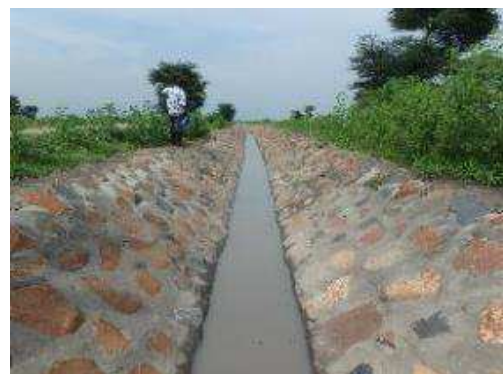
Masonry lining canal (Behekala scheme, Igunga, Tabora)
